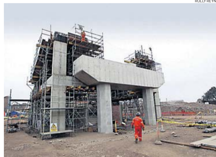
AVANCES. Los dos puentes del Metro de Lima estarán listos a fines del 2013. La construcción de la vía terminará en setiembre del 2014.
